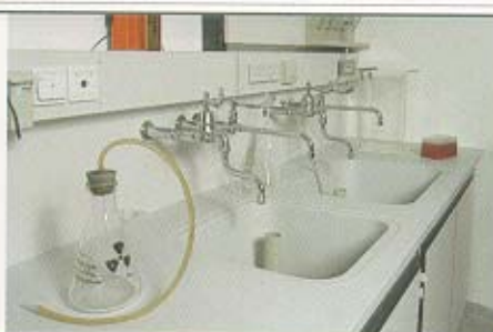
Nahtlos verarbeitete Varicor®-Arbeitsflächen und Becken entsprechen höchsten hygienischen Ansprüchen und sind weitestgehend chemikalienresistent
