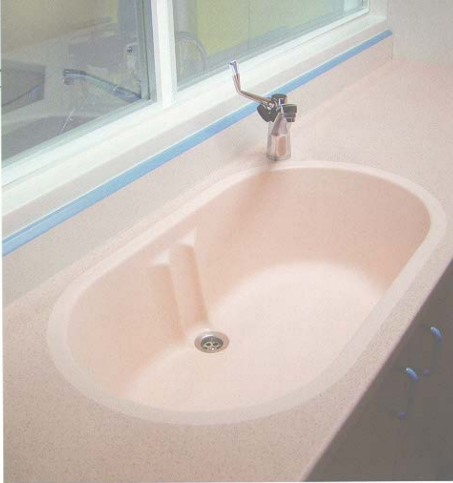
Varicor®-Säuglingspflegebecken mit beidseitiger Kopfschräge, Arbeitsplatte und Wandanschluss
