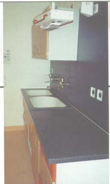
Säuglingspflegebecken, Arbeitsfläche und Rückwandverkleidung aus Varicor®
